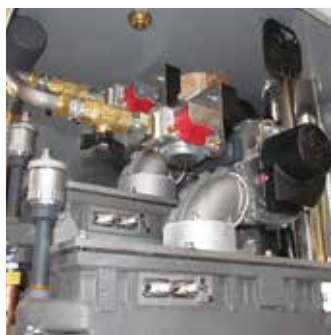
Egységek: ventilátor, modulációs gázszelep, premix égő
